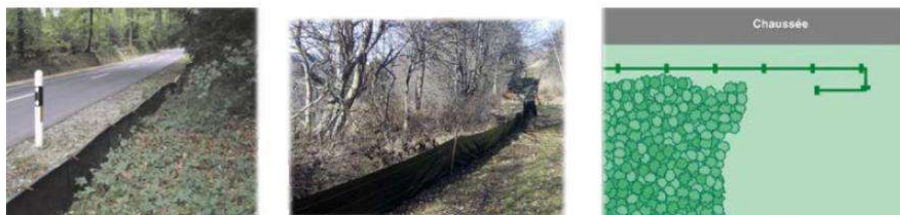
Figure 177 : Exemples de dispositifs de mise en défens : plaques rigides (à gauche) et bâche souple (au milieu), schéma de retournement de la barrière à son extrémité libre (Source : NATURALIA - 2022)
