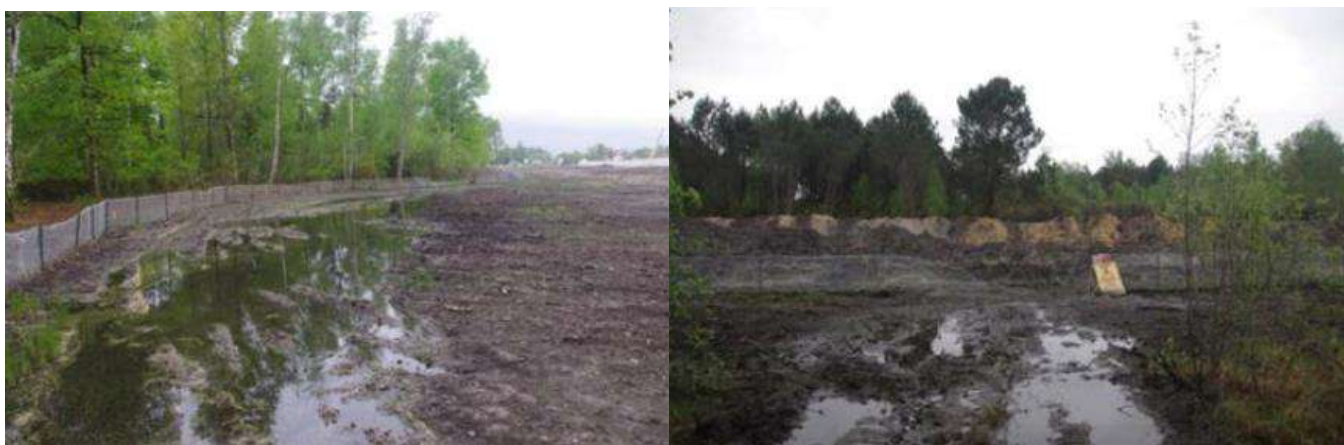
Figure 179 : Ornières et flaques aux amphibiens créés par des engins de chantier (Source : NATURALIA - 2022)
